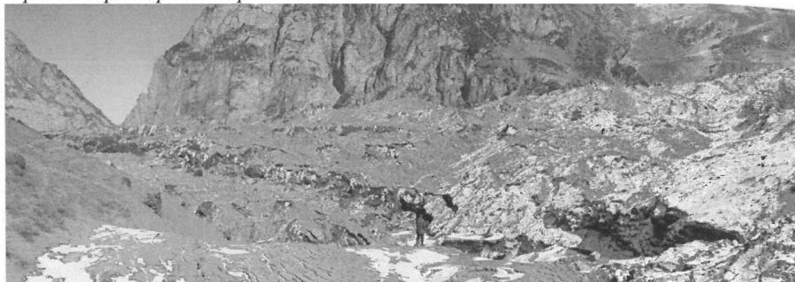
Рис. 7. Оползень в Кармадонском ущелье (Северная Осетия)
