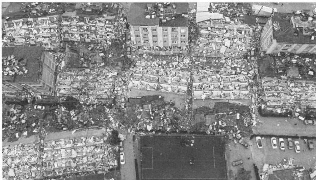
Рис. 3. Последствия землетрясения в Турции в 2023 г.
